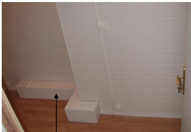
Les systèmes d'aération sont acoustiquement traités
